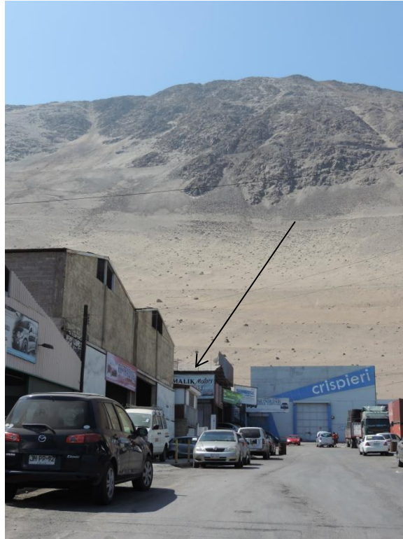
Figura 6-12 Caída de rocas activa en sector industrial de Iquique.
