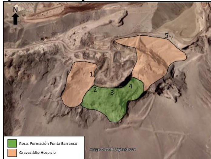
Figura 11-22: Sectores geotécnicos identificados en Cantera 6
